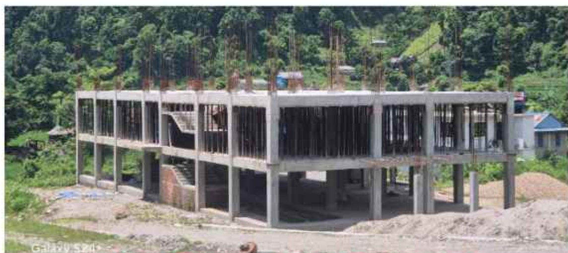
गाउँपालिकाको केन्द्र तालुङ्गामा निर्माणाधीन गाउँपालिकाको प्रशासकिय भवन
